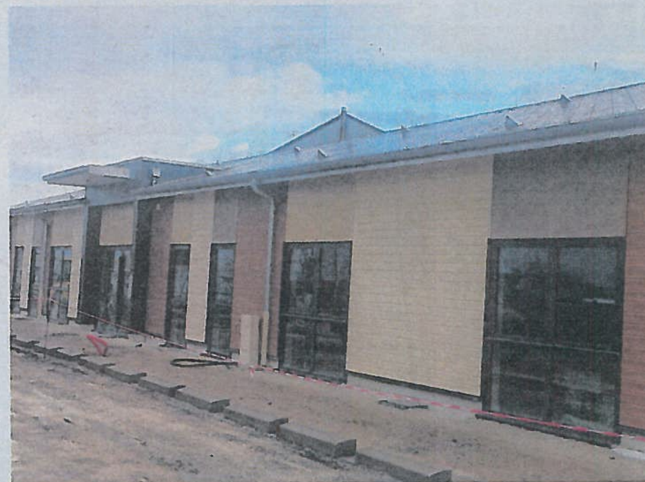
Les travaux de la maison médicale de Crégy-lès-Meaux avancent vite.
